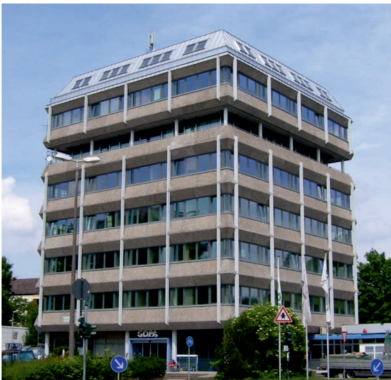
Bürohochhausanierung Bad Homburg mit 3000 m 2 bewa-Kunststofffenstern Ausführung mit 3-fach Wärmeschutzverglasung
